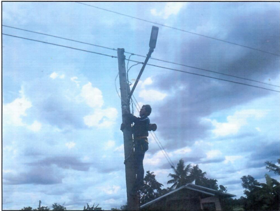
ภาพดำเนินการซ่อมไฟส่องสว่างสาธารณะบ้านโกรกไม้แดง
